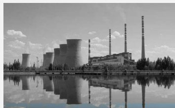
圖 4：坐落於海邊的發電廠
